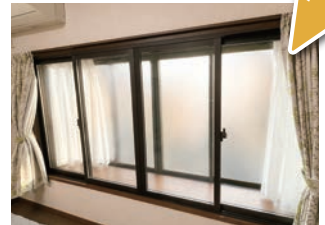
内窓設置（出窓へ取り付け）
